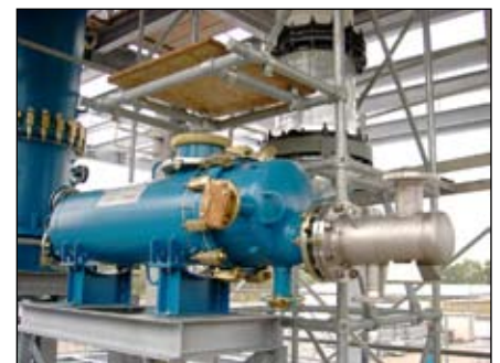
Bild 6: Anlage während der Montage: Verdampfer, Email und Borosilicatglas-Kolonnen
